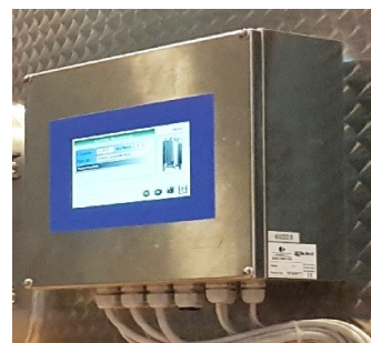
Quadri di controllo temperature con visualizzazione per singolo serbatoio
