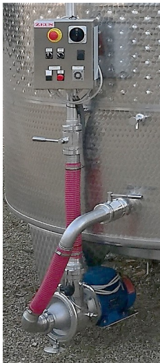
Rimontaggio automatico con quadro Inox AUTOMATICO/MANUALE tempi di LAVORO/PAUSA
