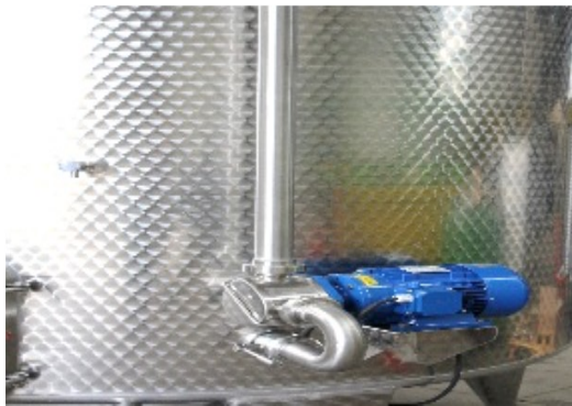
Diffusore STATICO DN40-50 a piatto sagomato e regolabile
