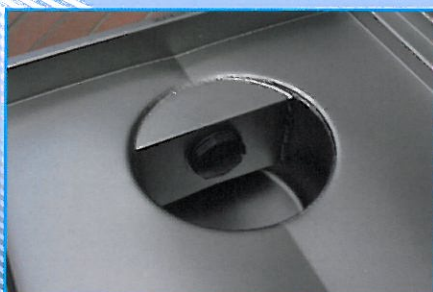
PARTICOLARE SIFONE SU VASCA LAVAGGIO
